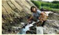
佐倉市神門 再生土埋立て現場
