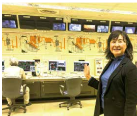
1/22 市川クリーンセンター
